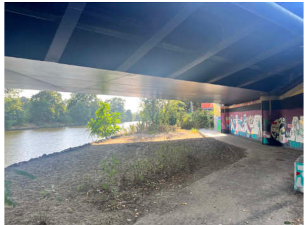
1 Unter der Südostalleebrücke
