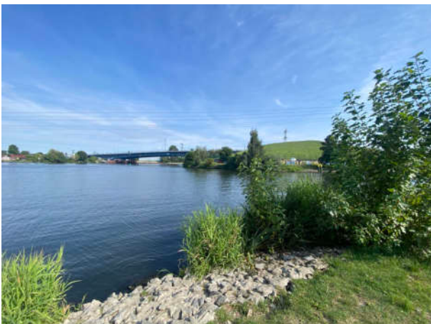
7 Deckwerk an der Spree
