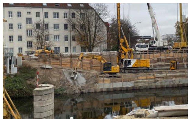
1 Baustellenrampe an der Marggraffbrücke
