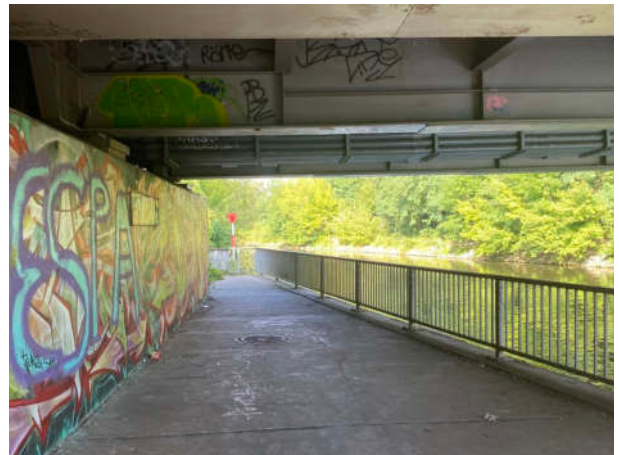
1a Unter der Kieffholzbrücke
