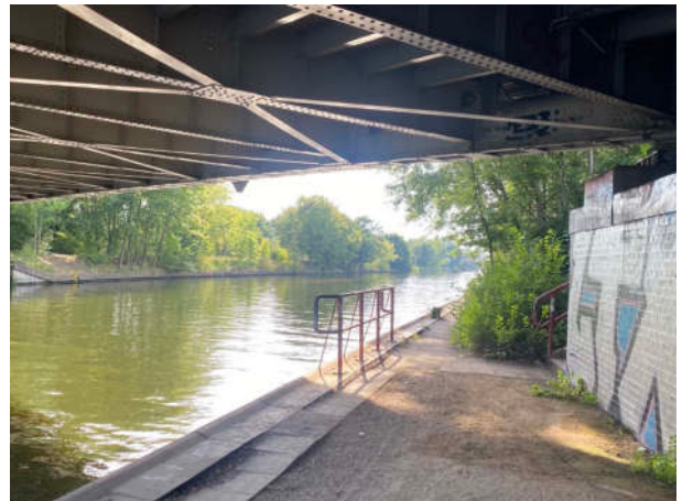
1 Unter der Baumschulenbrücke
