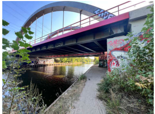
1 Unterquerung der Eisenbahnbrücke
