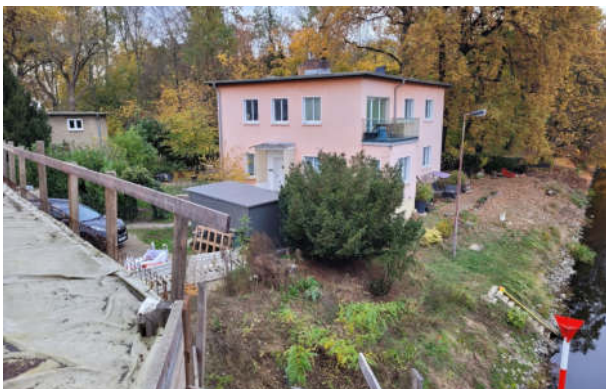
3 WSA-Fläche zwischen Privatgrundstück und Kanalufer
