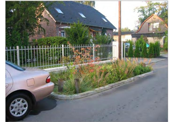
Abbildung 13: Beispiel für ein Tiefbeet-Rigolen-System (Foto: IPS)
