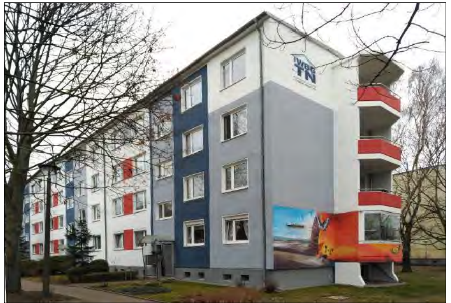
Abb. 12: Sanierter Q3A-Wohnungsbau im Ortsteil Plänterwald (Foto: Planergemeinschaft)
