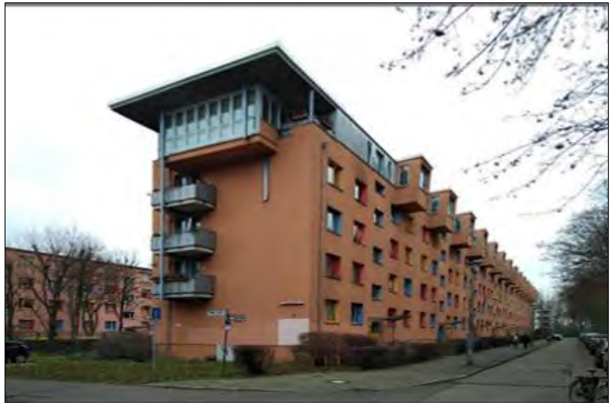
Abb. 25: Eine der wenigen Dachgeschoss-Aufstockungen der Bauserie Q3A im Fördergebiet (Bergastraße) (Foto: Planergemeinschaft)
