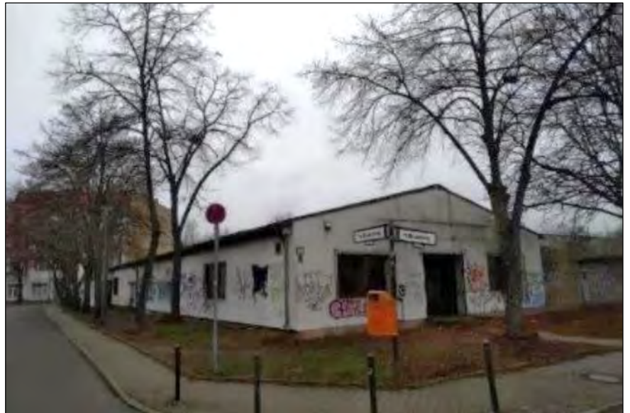
Abb. 43: Ehemaliger Drogeriemarkt am Heidekampweg (Foto: Planergemeinschaft)
