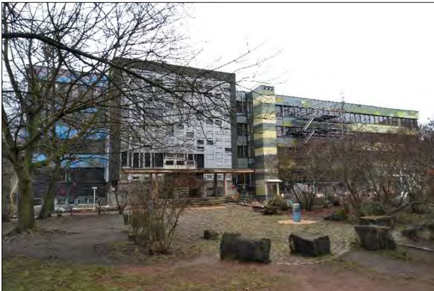
Abb. 14: Sanierungsarbeiten an der Schule am Wildgarten (Foto: Planergemeinschaft)
