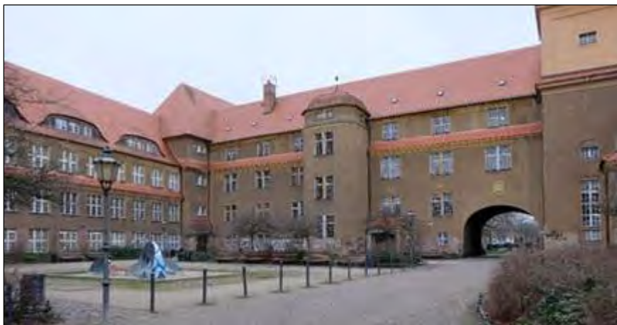
Abb. 72: Vorplatz VHS/Kirche: Stadtplatz mit funktionalem und gestalterischem Handlungsbedarf (Foto: Planergemeinschaft)
